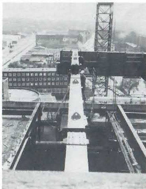
Stålmontage på Nordkraft højt over byens tage
